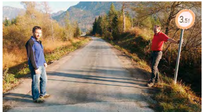
Vize-Bgm. Peter Politschnig und WL Horst Schwenner besichtigen die sanierte Dammstraße welche vom Sportplatz in Richtung Flugplatz führt.
