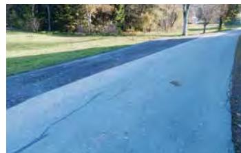
In Kreublach wurde gemeinsam mit dem Grundeigentümer der Straßenverlauf vermessen und eine geringfügige Verlegung vorgenommen.
